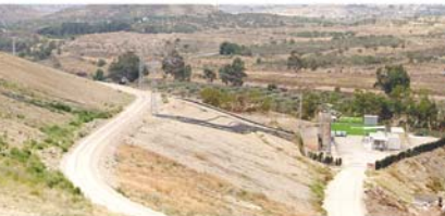
PLANTA DE BIOGÁS
